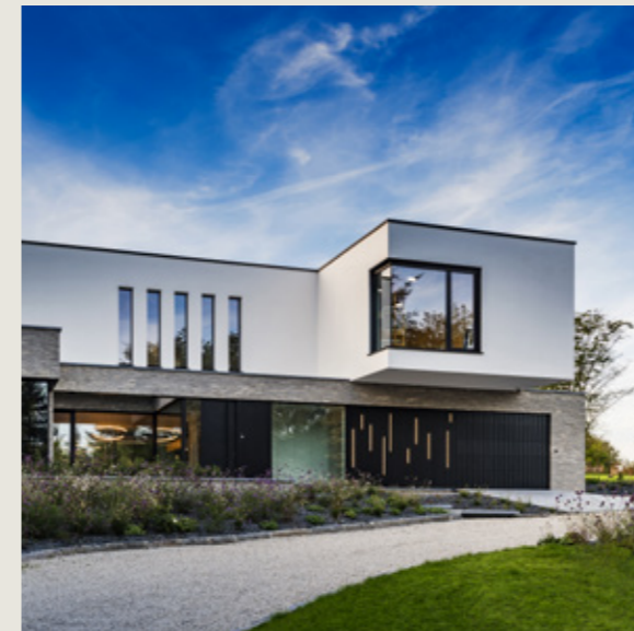
Füllungen mit LED-Modulen
